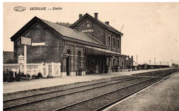
Het voormalig stationsgebouw van Deerlijk is van het type 1881-1895 R5 gebouwd in 1892
