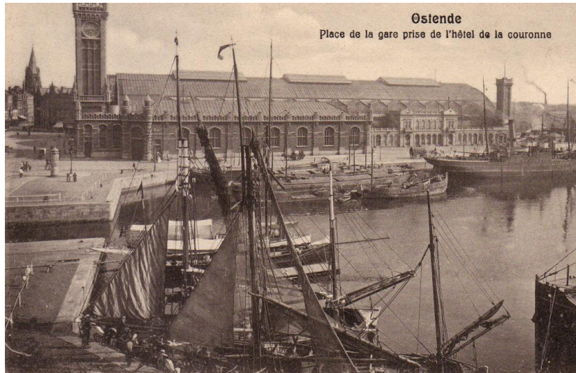
Het station van Laureys met het ingebouwde station van Payen
