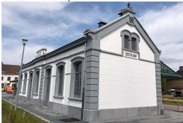
Het gerestaureerde en geklasseerde station, verplaatst naar de overzijde van het nieuwe station
