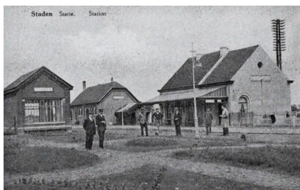
Het stationscomplex te Staden na de Eerste Wereldoorlog met het wederopbouw-station.
